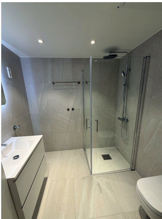
Det er benyttet baderomskabiner i utbyggingen.
