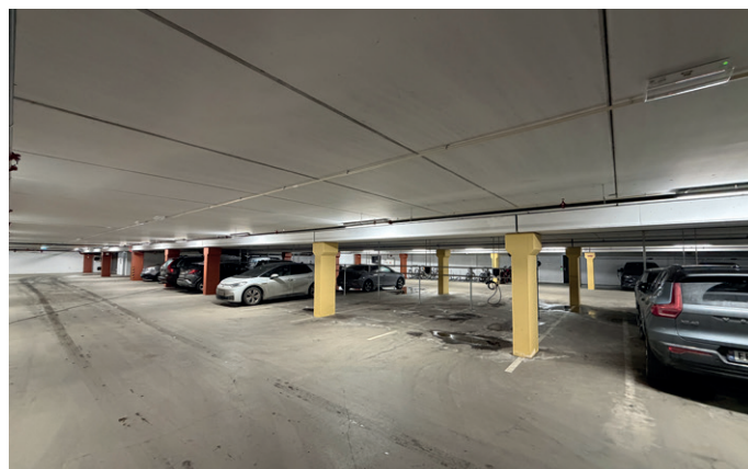
Det er en stor parkeringskjeller som er bygget felles for alle de tre byggene
